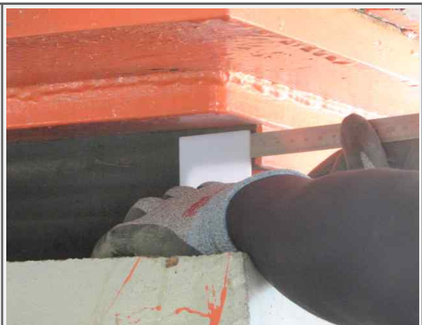
P1 교량받침 이동량 측정(영천)
