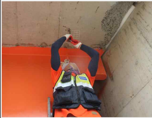
상부구조 탄산화깊이 측정
