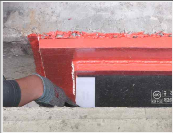
A1 교량받침 이동량 측정(영천)
