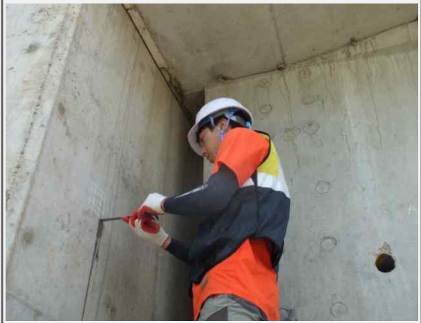
하부구조 탄산화깊이 측정
