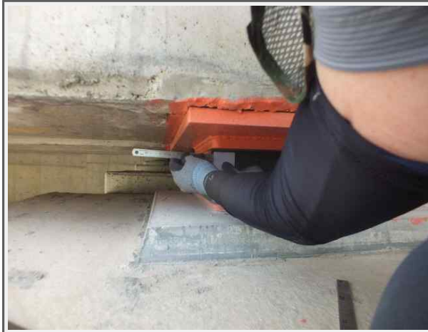
A1 교량받침 이동량 측정(상주)
