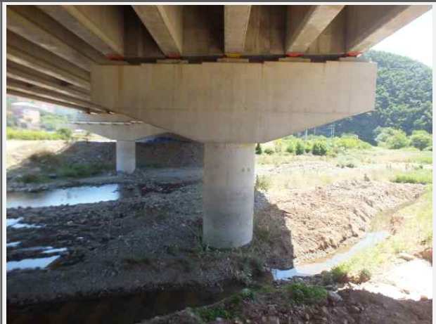
내 용 배골교(영천) 교각
